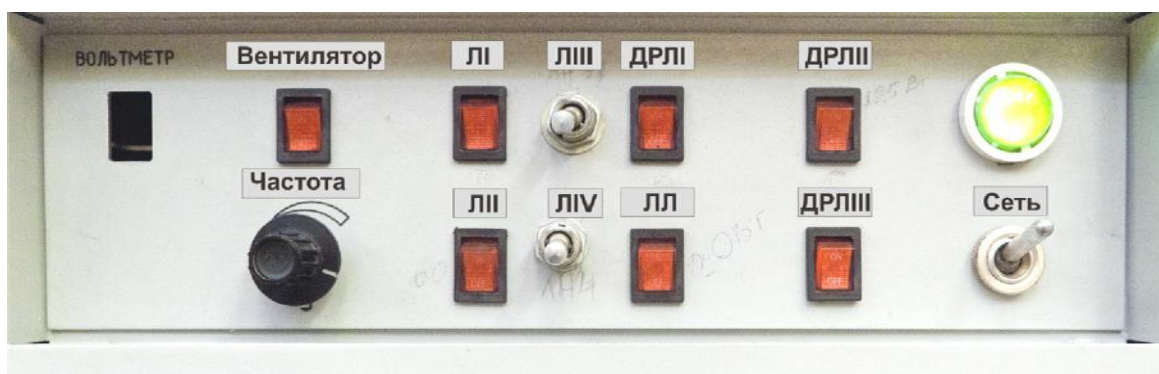
Рис. 4.3. Панель управления лабораторной установки БЖ 1
